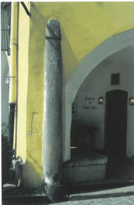
Abb. 7: Granitsäule als vermutlicher Träger des auszuhängenden Marktzeichens. Die ab Bodenniveau 3,5 m hohe Säule ist an den Ecken abgefast, hat unten 88 cm Umfang und verjüngt sich nach oben. Auf der Höhe 1,55 m ist eine Einstecköffnung von 12 mm Durchmesser, bei 3,30 m eine weitere mit 20 mm. So ist durchaus vorstellbar, daß hier einmal ein Haken zum Einstecken des Marktzeichens angebracht war.
