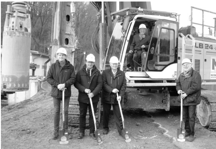
Alexander Huber vom Bauamt, Bauleiter Marcel Penzel, Planer Anton Mader und Zweiter Bürgermeister Werner Gartner beim offiziellen ersten Spatenstich. Erster Bürgermeister Michael Kölbl durfte ans Steuer des riesigen Drehbohrers.
