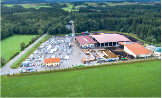
Vergärungs- und Kompostierungsanlage Aham
